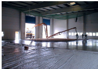
Die Betonplatte wird gegossen 1998
