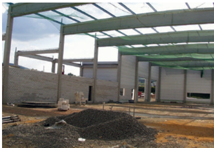
Rohbau ohne Bodenplatte
